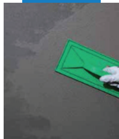
Трамбовка Maregrout 430 (Maregrout 430)
